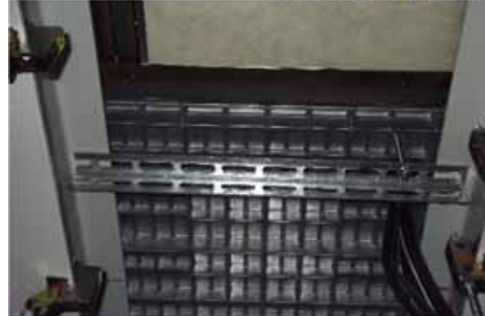
建屋の梁 (H鋼) を跨ぐようにアングル材を渡し、そこにボルトで固定。
