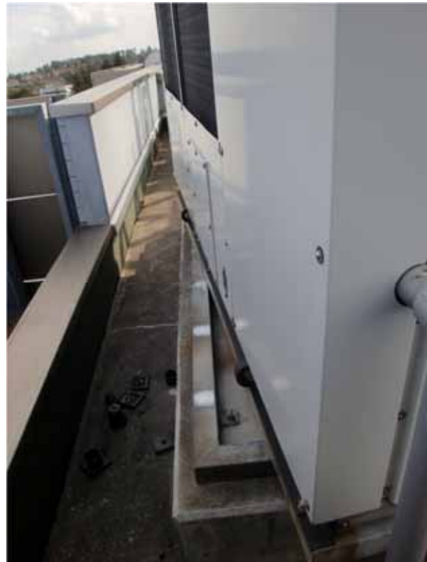
支持しているダンパが破損し、移動・故障した空冷チラー
