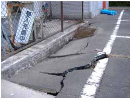
陥没したMNC外周のアスファルト
