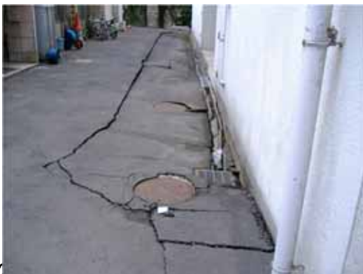
陥没したMNC外周のアスファルト
