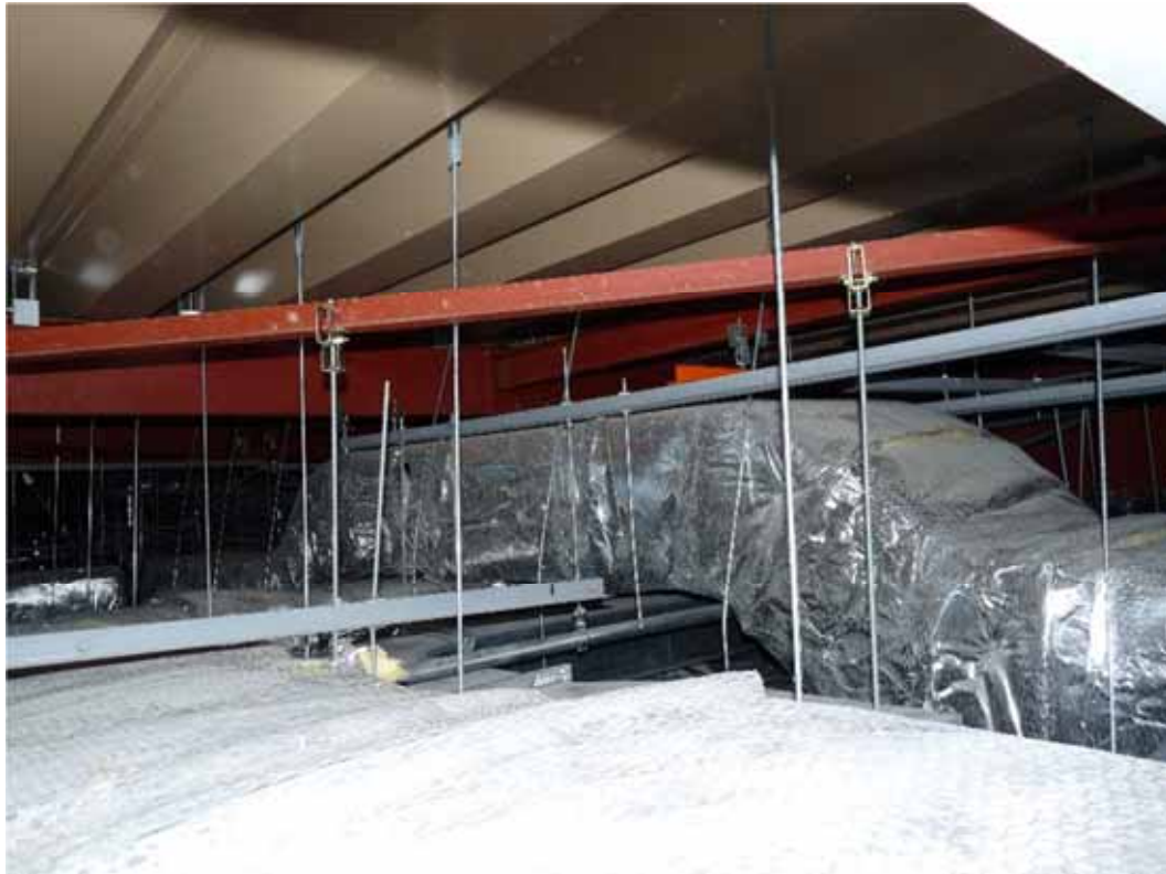
天井が揺すられ、曲がった吊りボルト。横方向に渡した揺れ止めがない。
