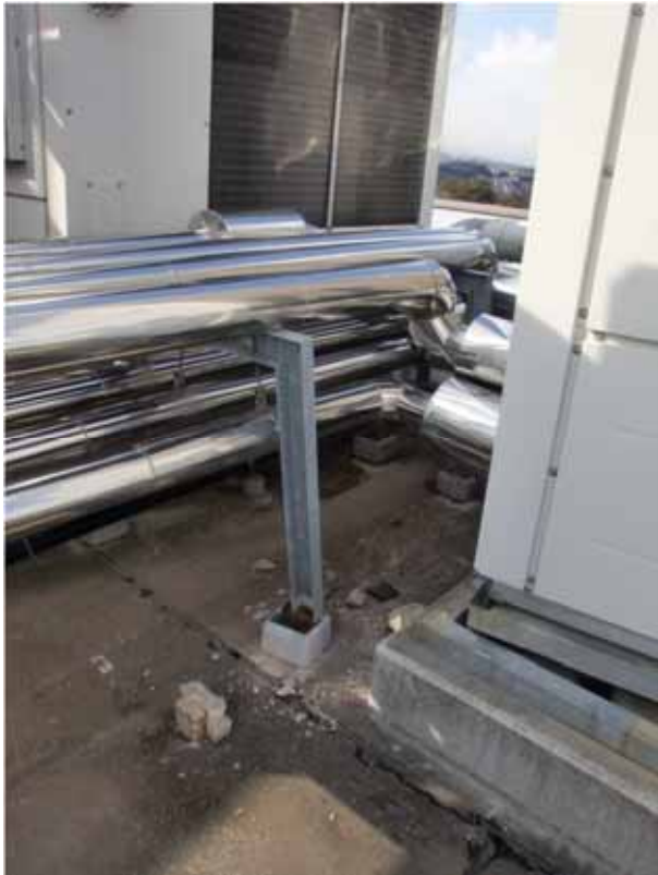
11 支柱が破損し、歪んだ冷温水パイプ
