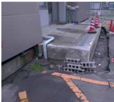
陥没した建物外周のアスファルト (2011.6.28)
